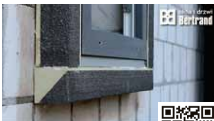
Montaż systemem MOWO
