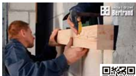
Montaż systemem Thermo WOOD
