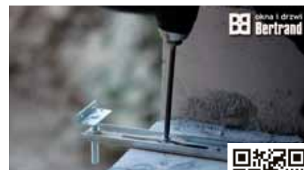
Montaż wysunięty w przestrzeni izolacji budynku na konsolach
