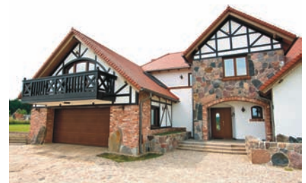
Menuiserie extérieure et intérieure pour des maisons individuelles
