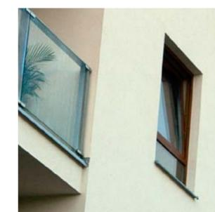
Ai clienti che apprezzano il legno naturale, ma vogliono una finestra che duri nel tempo e con costi di manutenzione minimi, offriamo le finestre in legno-alluminio **Alutrend**. Nella loro fabbricazione è utilizzato nel lato interno legno naturale e all' esterno un rivestimento di alluminio resistente alle intemperie e facile da pulire.
